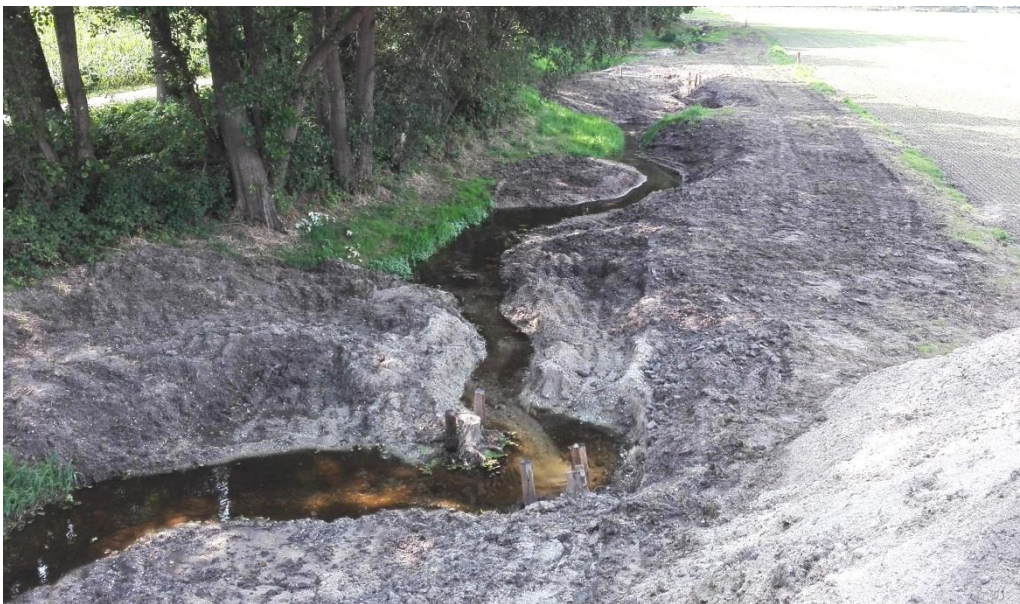
Die renaturierte Kleine Renne nach der Fertigstellung
