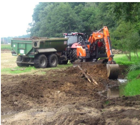
Die Maßnahme wurde vollständig von unseren Mitarbeitern umgesetzt.
