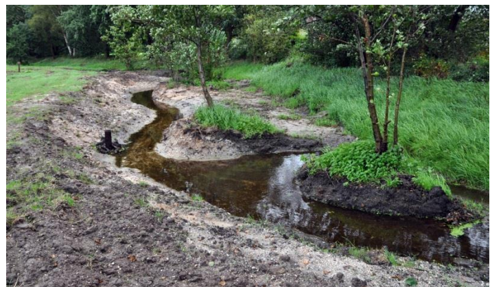
Durch den Bau von Uferbänken und Inseln sind wertvolle Lebensräume in der Wasserwechselzone entstanden.
