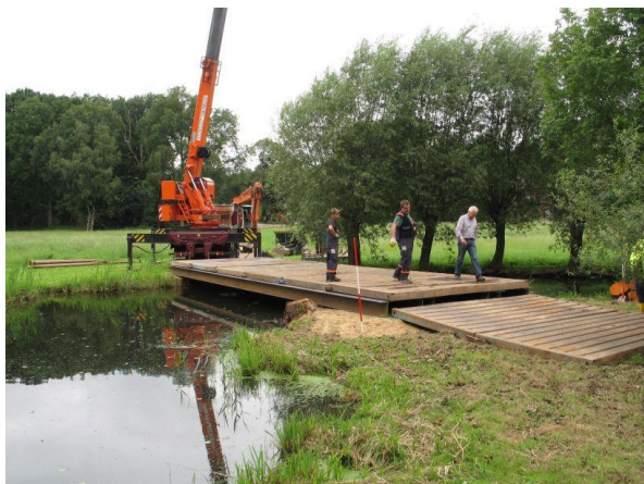
Bild 1 (oben): Vorbereitung der behelfsmäßigen Überfahrt
