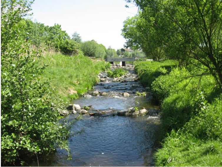
Foto 15: 2005/06 errichtete Sohlgleite am Auslauf des Windmühlenbruchs (Foto: Netteverband)
