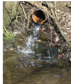
Typische bauliche Anlagen an Gewässern sind Verrohrungen an Verkehrswegen, Zäune oder Einleitungsbauwerke
