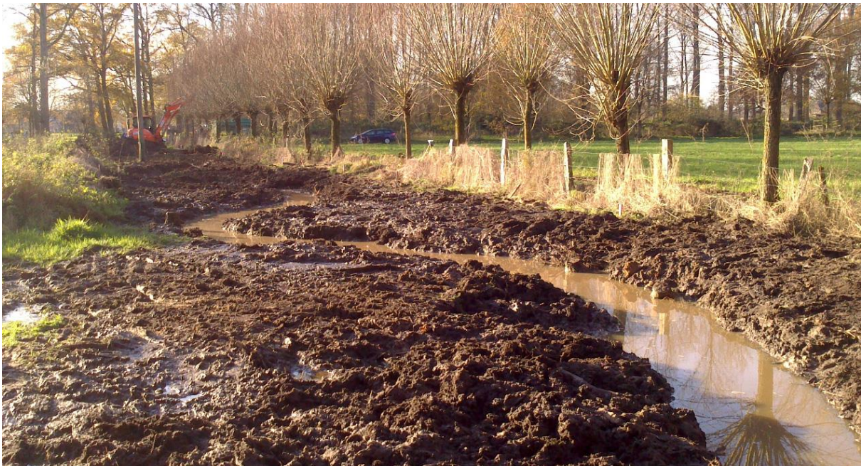
Das umgelegte und naturnah gestaltete Gewässer kurz nach der Fertigstellung Ende 2015
