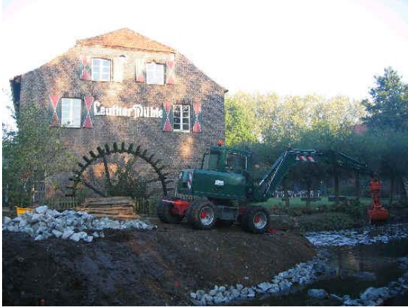
Bild 3: Einbau der Steinschüttung
