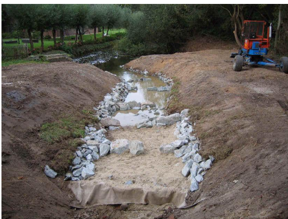
Bild 1: Fischaufstiegsanlage im Bau: Dichtung mit geosynthetischer Tondichtung (Bentonitmatte)
