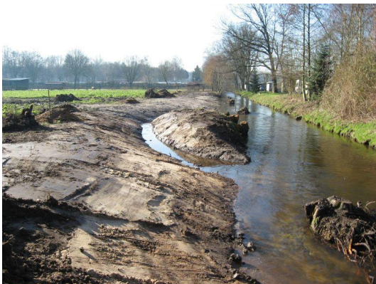
Bilder 1 und 2: Uferabflachung und Einbau von Strömungslenkern an Nette (links) und Kleiner Renne (rechts)
