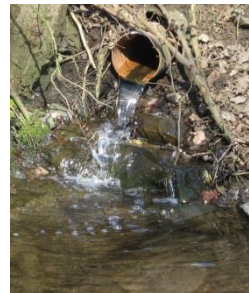
Typische bauliche Anlagen an Gewässern sind Verrohrungen an Verkehrswegen, Zäune oder Einleitungsbauwerke
