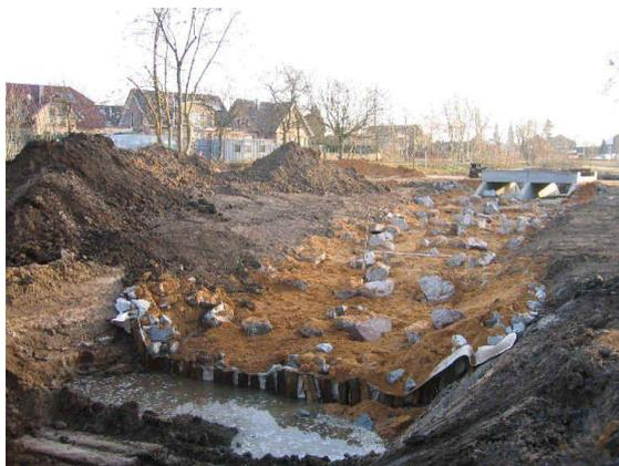
Bild 1 (links): Sohlgleite im Bau
