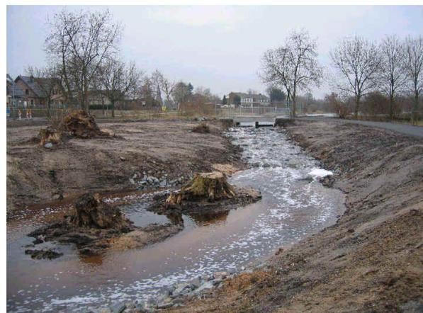
Bild 2 (rechts): Sohlgleite unterhalb des Ablaufbauwerks nach Bauausführung
